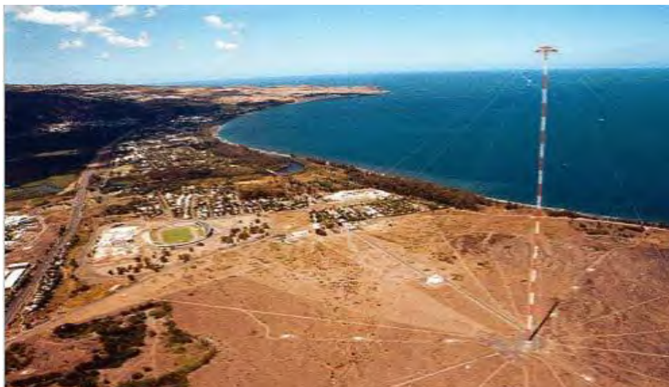
Pylône Oméga de la plaine Chabrier – Cliché Chriss internet
